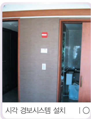
시각 경보시스템 설치 | ○
