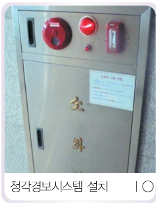
청각경보시스템 설치 | ○
