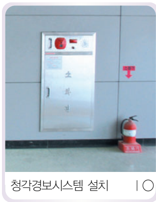
청각경보시스템 설치 | ○
