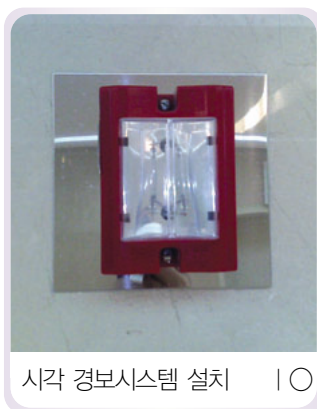
시각 경보시스템 설치 | ○
