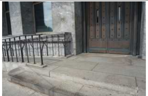
자연재료로 경사로 설치(기존 시설과 조화)
