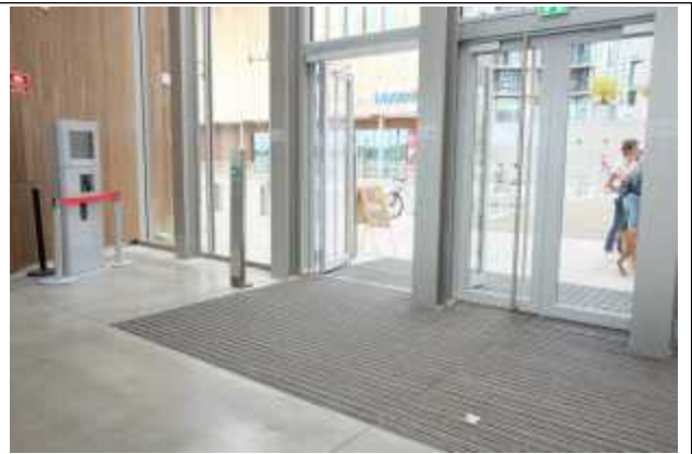
주출입구- 휠체어사용자용 출입구 별도 설치 개폐스위치 출입문 전면에 설치
