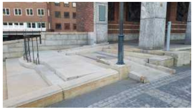
자연재료로 경사로 설치(기존 시설과 조화)
