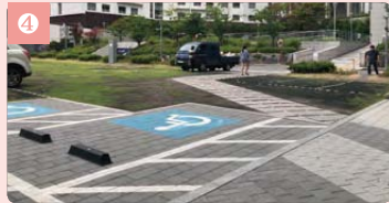
4 주차장에 접근로(차량 교행) 신설 ▶ 접근로 기준 부적합
