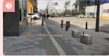
3 보행장애물 추가 설치 ▶ 접근로 기준 부적합
