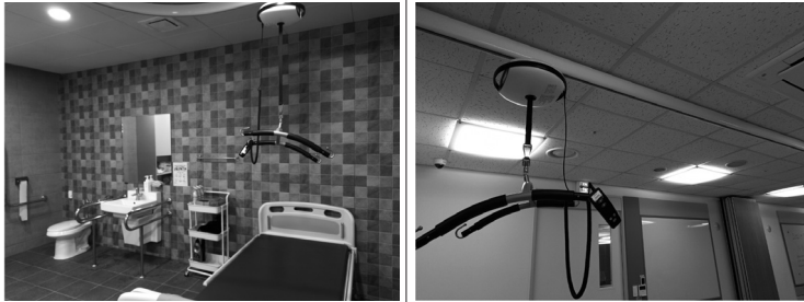
그림 III-3-14 호이스트 설치 사례
